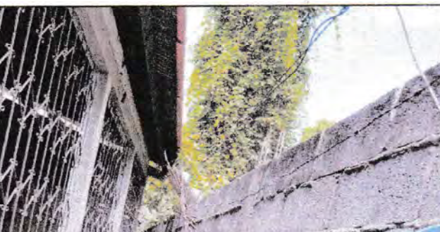
Foto 5: Sustrucción de tubo PVC de 3" por canales de metal. Parte de atrás de dos aulas, por motivo que los canales actuales están en mal estado y cuando llueve el agua rebota en el tapial y salpica hacia dentro de las aulas.
